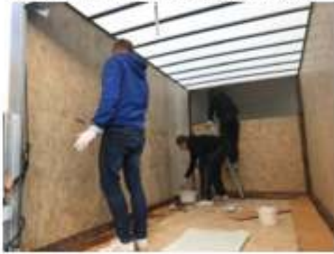
VAN LINING FIBREGLASS
